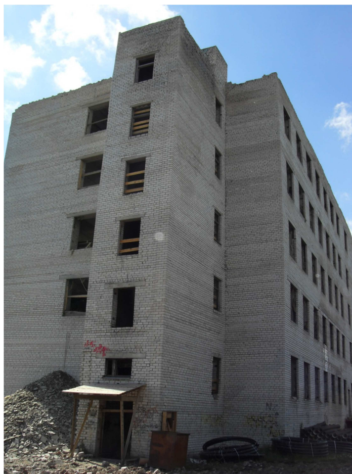
Рис.3. Общий вид фасада на пересечении осей «1-А».
