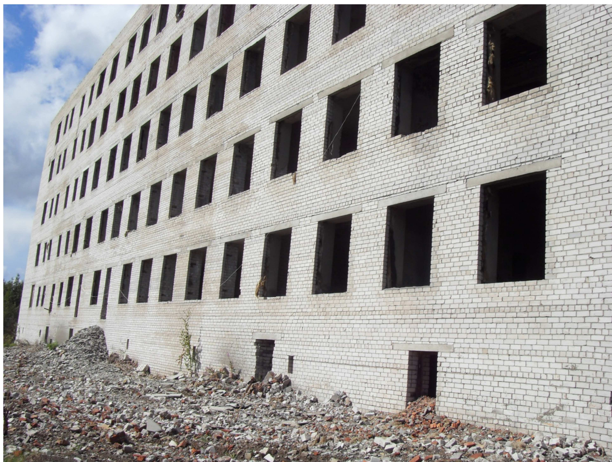
Рис.2. Общий вид фасада по оси «Д».
